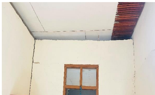
Mauer des Internats
