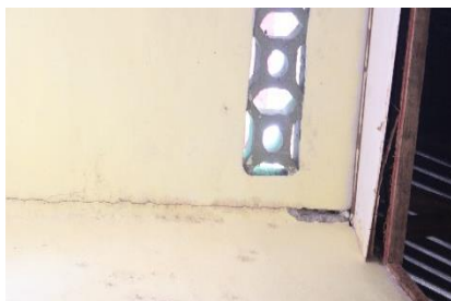
Risse in der oberen Ecke des Klassenzimmers Abgelöster Wandputz im Klassenzimmer
